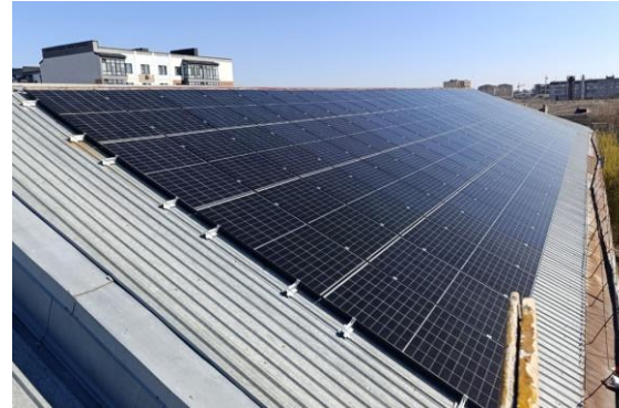
Рисунок 1 – Розміщення полів фотоелектричних модулів мережевої та гібридної ФЕС на даху головного корпусу ІФНТУНГ (1– мережева ФЕС; 2 – гібридна ФЕС)
